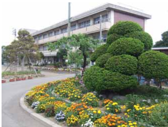
【広田小学校の全景】
