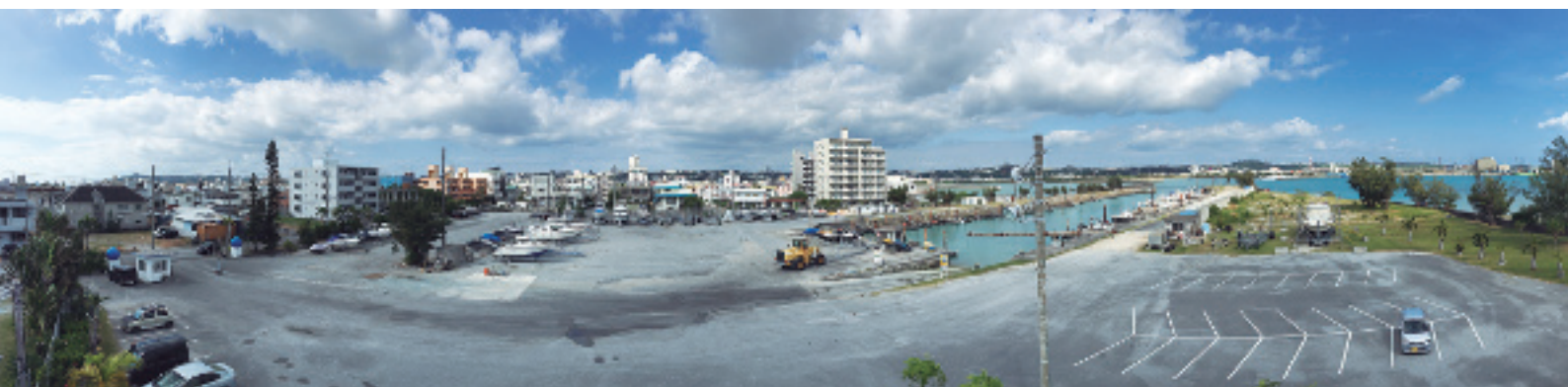
クラブハウス屋上からマリーナ敷地を望む
